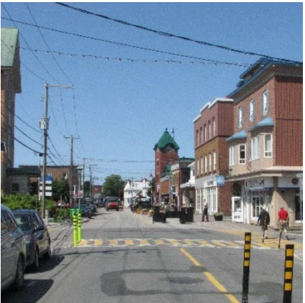
3. Discontinuité des activités commerciales en rez-de-chaussée
