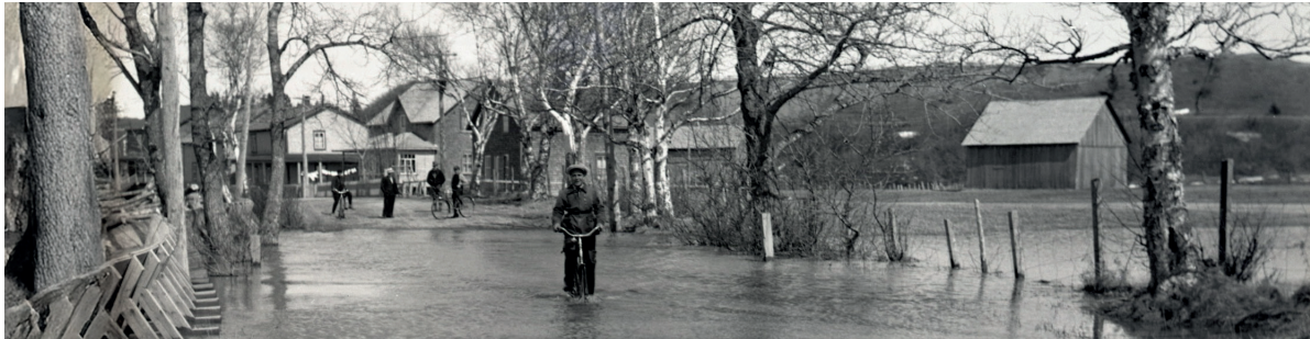
Inondation dans le secteur du Grand-Détour.
